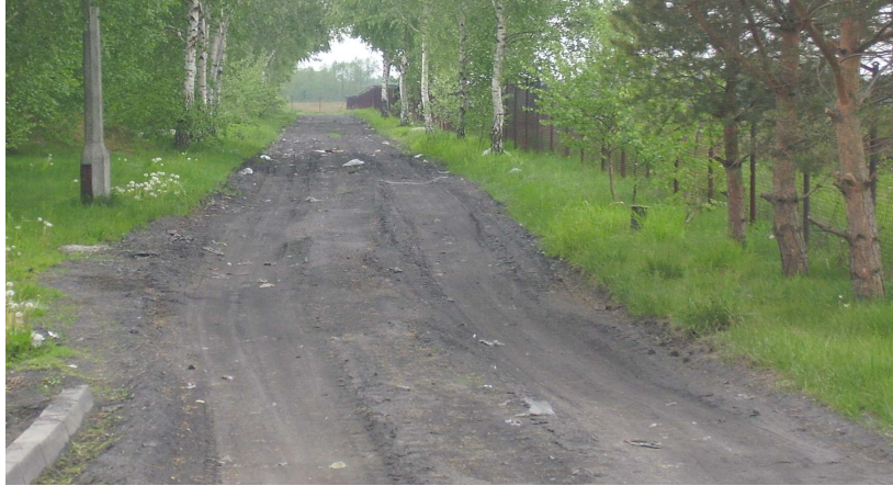
Fot. 2 Składowisko odpadów komunalnych – droga dojazdowa do składowiska odpadów
