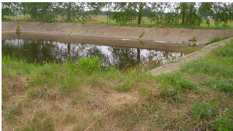
Fot. 3 Składowisko odpadów komunalnych – zbiornik p.poż.
